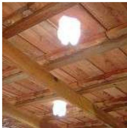
Figura2: Iluminação com garrafa PET parte interna do telhado<sup>5</sup>.
