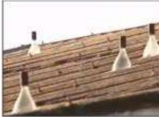
Figura1: Iluminação com garrafa PET parte externa do telhado<sup>4</sup>.
